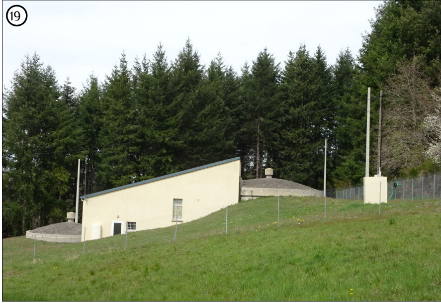
19 Une station d'épuration tangente la zone de projet
